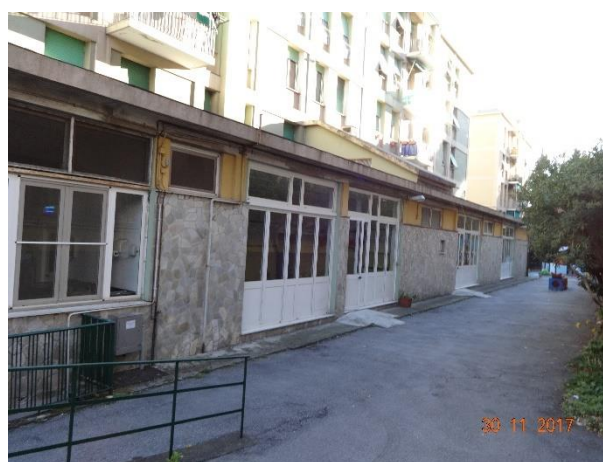
Figura 4.1 - Particolare della porzione di involucro esterno del fabbricato
